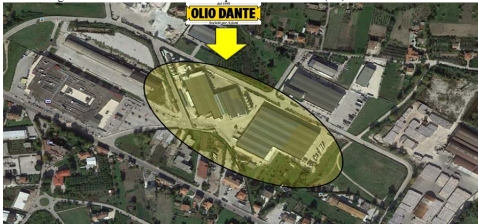
Grafico n.1: gli stabilimento della Olio Dante S.p.A. a Montesarchio (Bn) in Via Badia Zona Industriale
